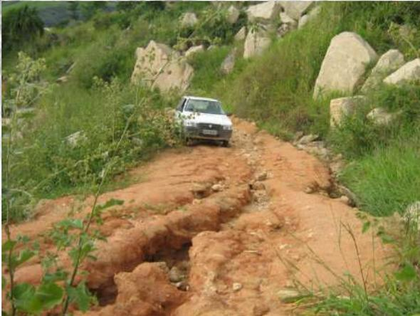
Figura 61 - Acessos sem manutenção tornam-se voçorocas.
