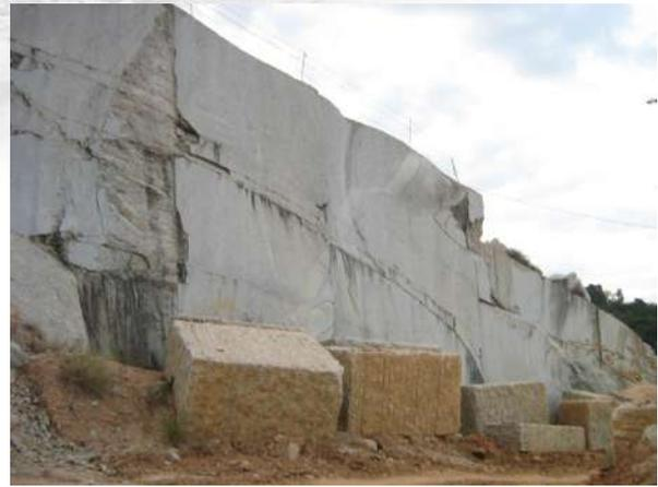
Figura 67 – Trincas na suite Carlos Chagas dificultam extração. Fonte: Ferma.
