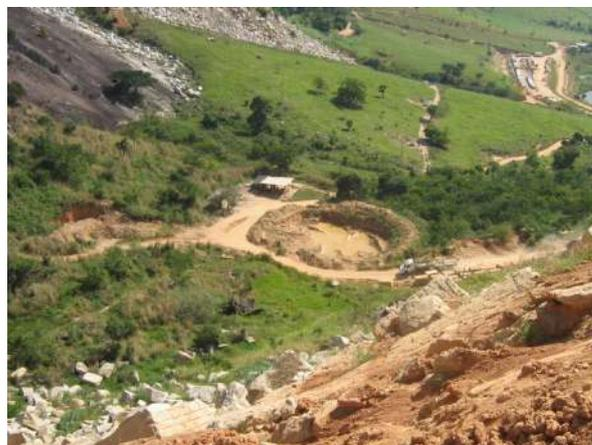
Figura 54 - Outro exemplo de lagoa de decantação para controle de assoreamentos. Fonte: Ferma.
